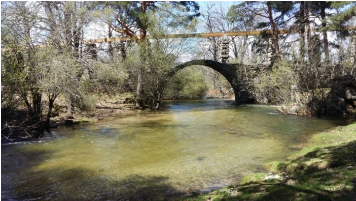
Puente de los Canales
