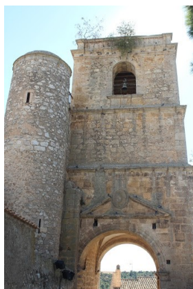
Iglesia de la Trinidad: torre campanario, arco de la villa y husillo cilíndrico
